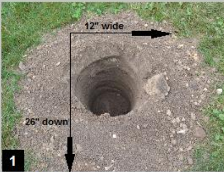
1 Dig Hole : Dig hole 12" wide x 26" deep
